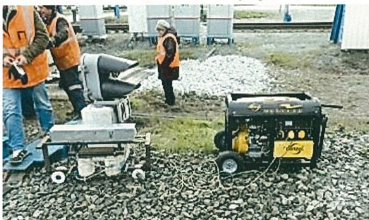
Фото 2. Подключение размагничивающего устройства к источнику питания
